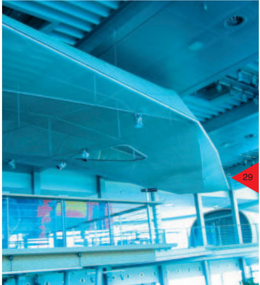
Bild 3: Einsatzbeispiel von nichtbrennbaren Glasgewebe im Messebereich
